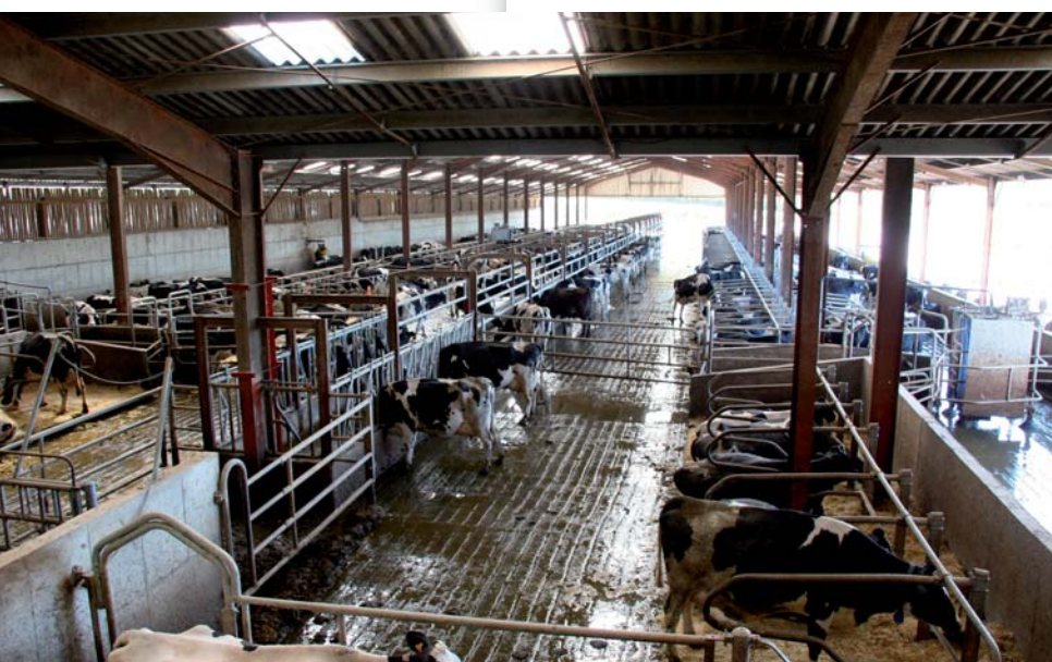
Le bâtiment est scindé en 2 parties strictement symétriques permettant une gestion du troupeau en 2 lots. Elles sont séparées par une table d'alimentation centrale sur tapis roulant de 91 m de long. Chaque lot dispose de 128 logettes et 2 stations VMS en circulation libre contrôlée.
